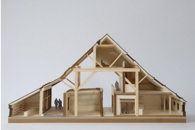
Foto: Friederike Tjaden. Schnittmodell eines Gulfhauses in Rysum mit neuem Nutzungskonzept.
